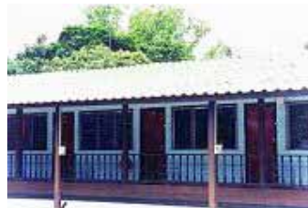
Seaside Fan Room
